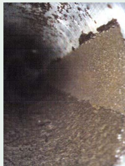
Imagen 3. A menudo la suciedad se decanta y acumula en la parte más inferior. Foto Hycam-Hypred
