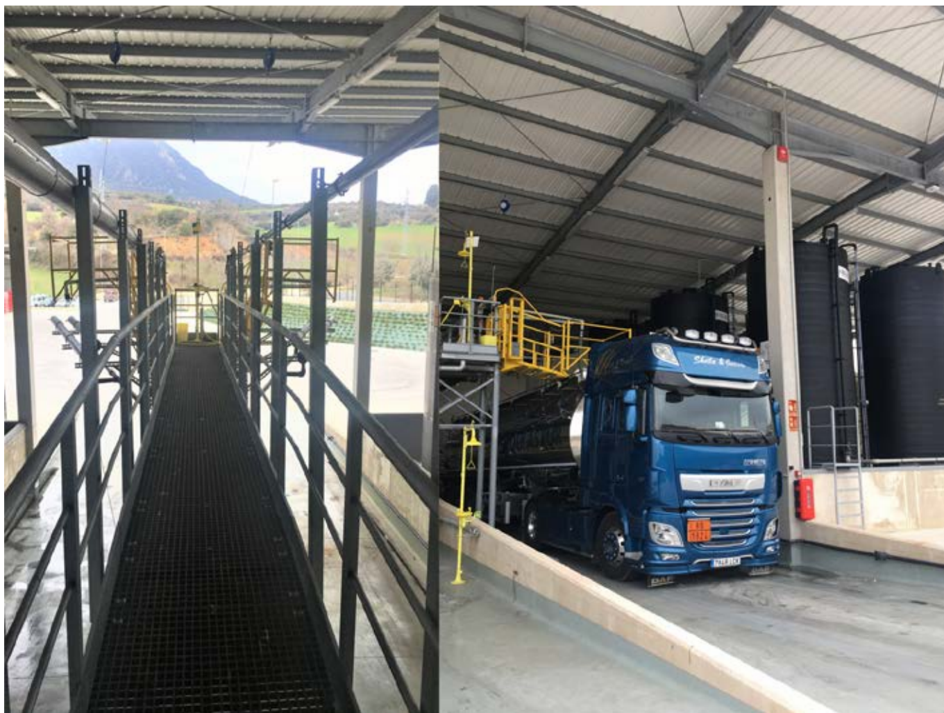
Imagen 3. Zona de muelles de carga y descarga de cisternas.
