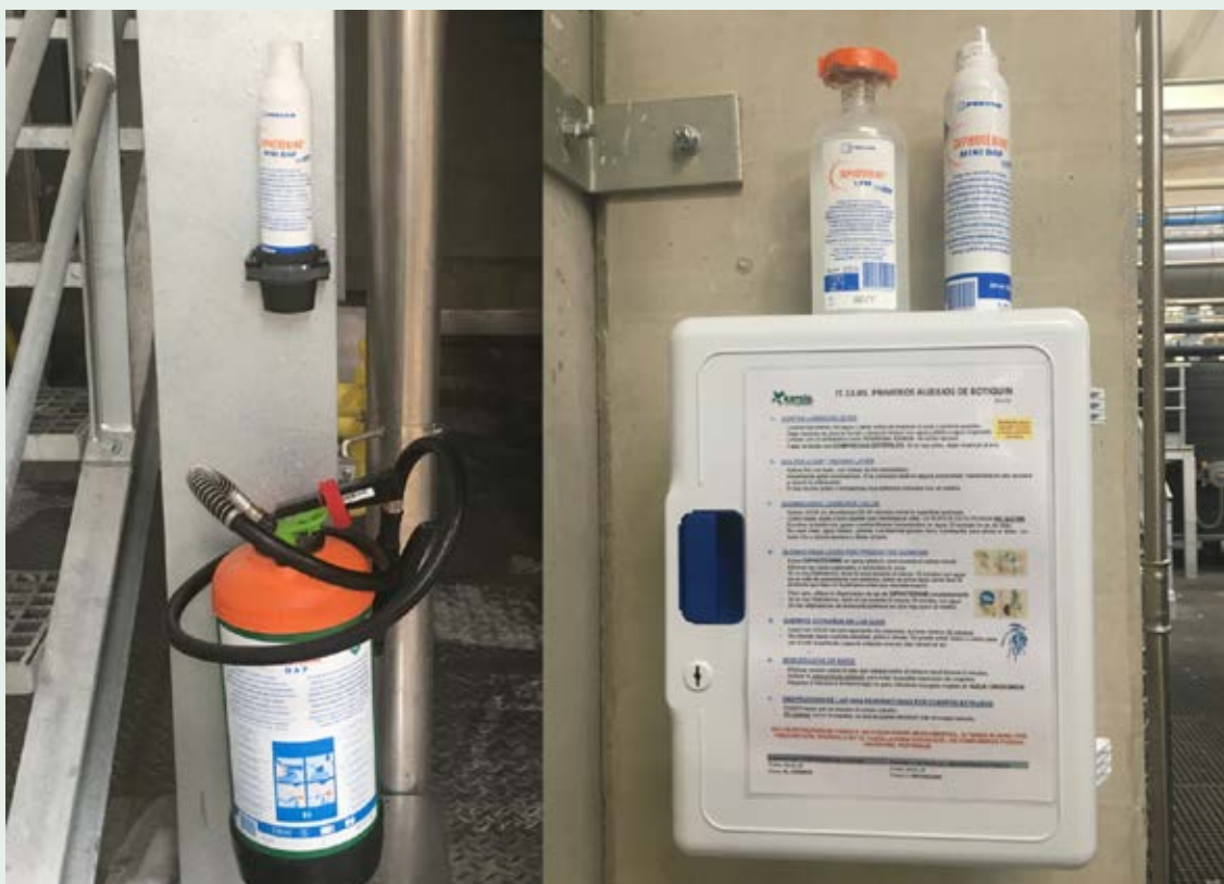
Imagen 1. Dispositivos con sustancias neutralizantes anfóteras para prevenir daños en piel y ojos en caso de salpicadura.
